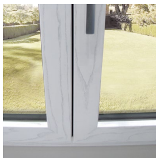
angoli a 45° e nodo centrale simmetrico
